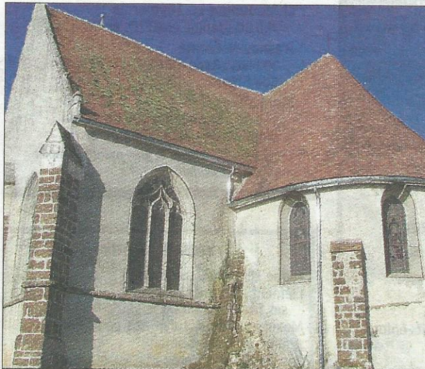
PATRIMOINE BÂTI. Les travaux de l'église Saint-Sauveur viennent de se terminer à Champrond-en-Gâtine.
