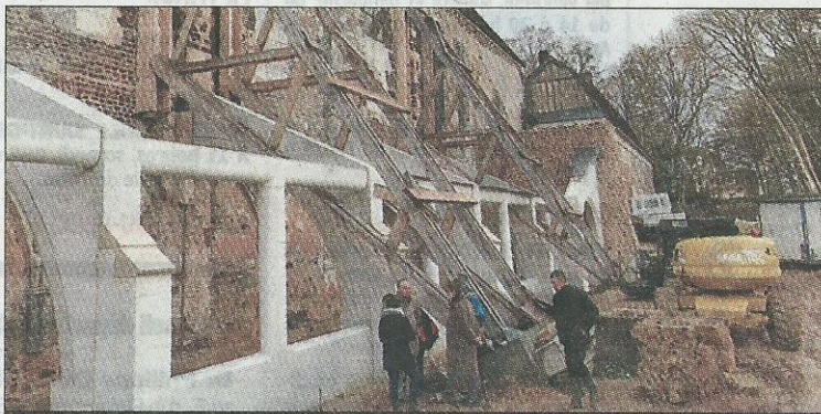
CHANTIER. D'importants travaux de consolidation ont déjà été effectués.
