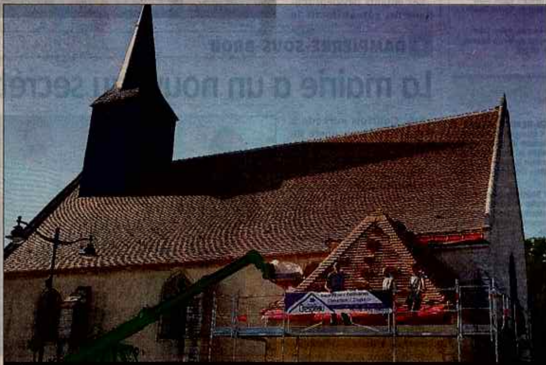
RÉNOVATION. L'entreprise de Mickaël Crespeau a été retenue par la mairie pour effectuer les travaux. PHOTO GAEËL TRÉVIEN
