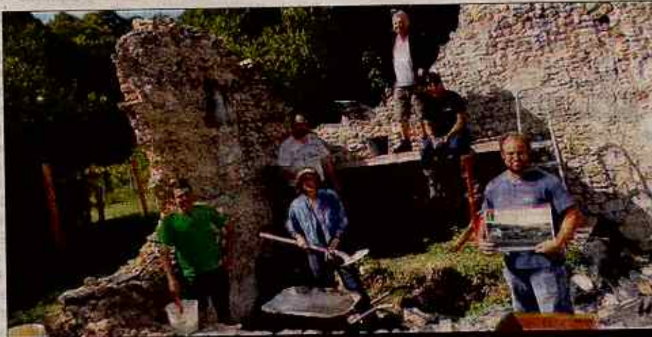
CHAPELLE. Les bénévoles ont attaqué les travaux de rénovation de la chapelle Saint-Évroult, d'après son état du XIX e siècle que l'on peut voir sur la photo ancienne tenue par Yoann Sorel.
