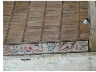
Poutre sablière (église Saint-Jean de Villeau)
