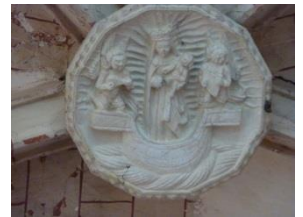
Clef de voûte (église de Bû)
